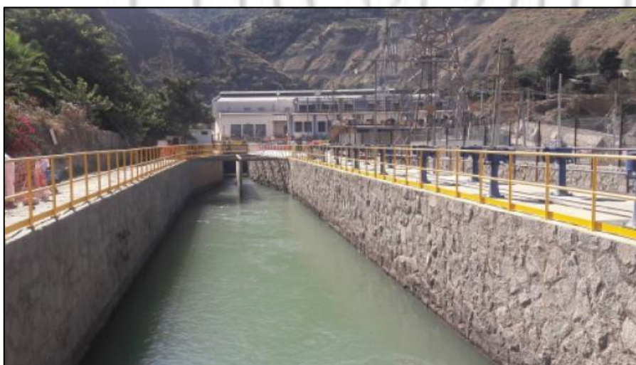
Figura 3 Central Hidroeléctrica de Moyopampa
