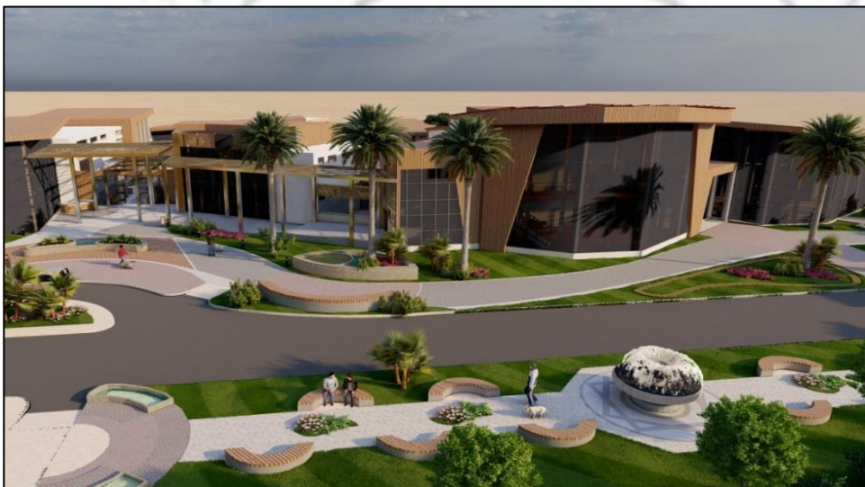
Figura 145 Fachada de Cafetería y Auditorio
