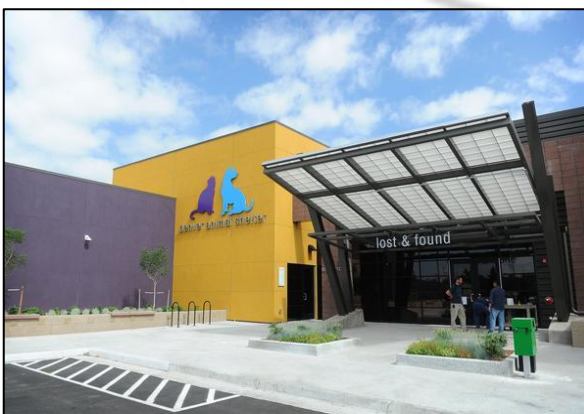
Figura 98 Fachada del proyecto
