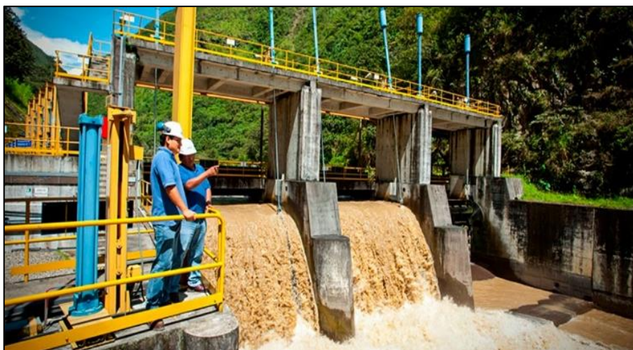
Figura 2 Central Hidroeléctrica de Huampaní
