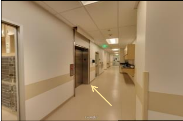
Figura 85 Circulación vertical - ascensor
