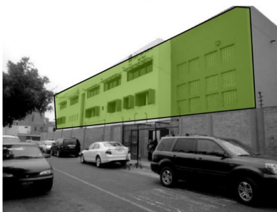
Figura 17 Vista Exterior-Centro Especial Ann Sullivan
