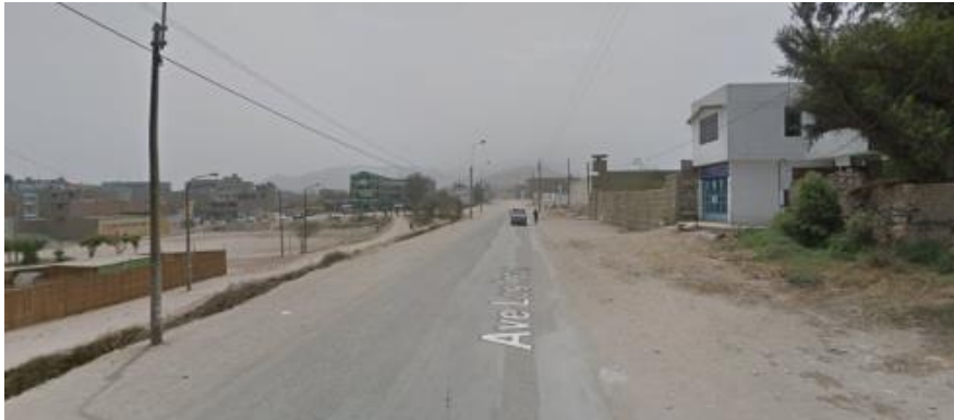
Figura 44 Vía secundaria Av. Los Incas
