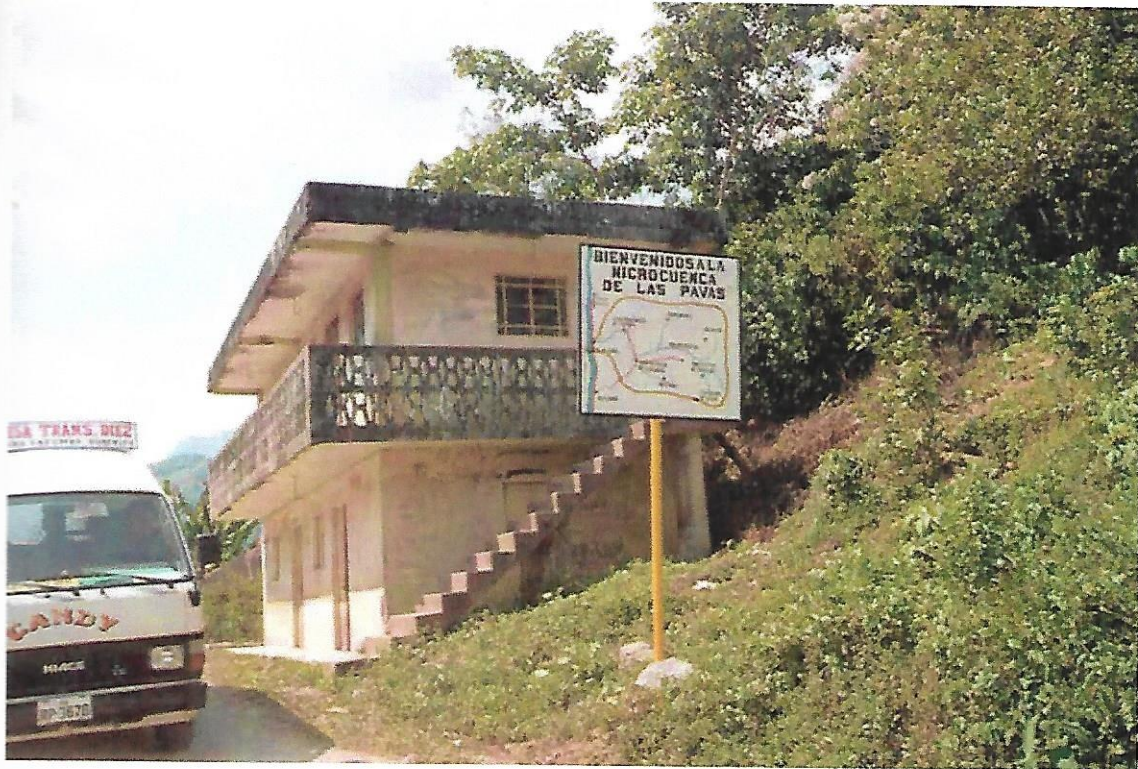
Ingreso a la microcuenca las Pavas carretera Santa Rosa de Quesada.
