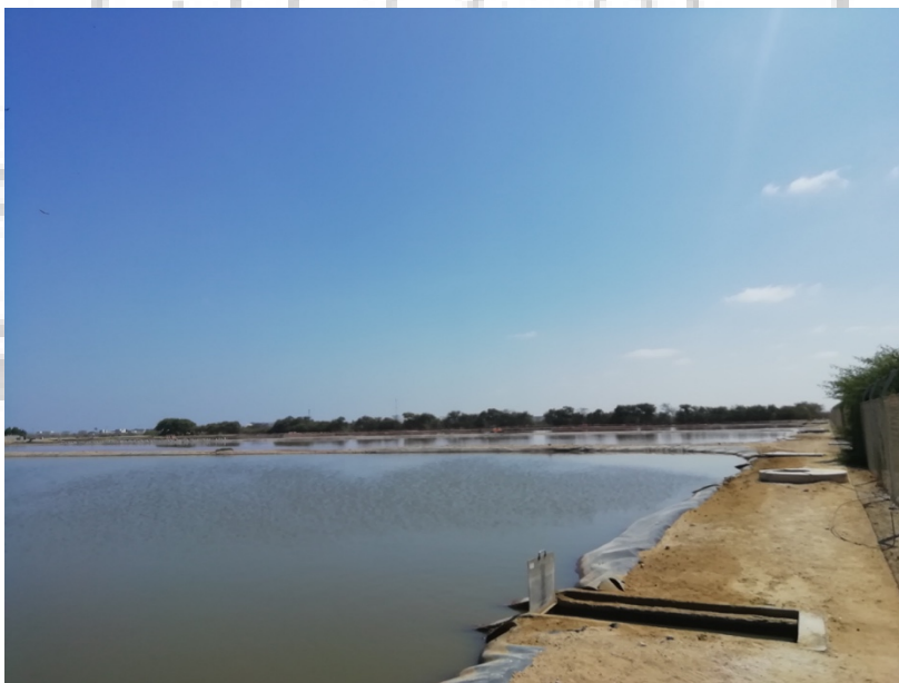
Piscinas tratamiento de aguas residuales ZED Paita (para riego de áreas verdes)
