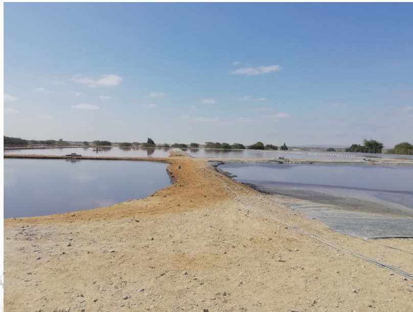
Piscinas tratamiento de aguas residuales ZED Paita (para riego de áreas verdes)
