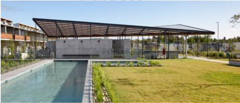
Figura 15. Centro de Recreación Hábitat – JFD Architects (Australia) Fuente: Archdaily Perú (2021)
